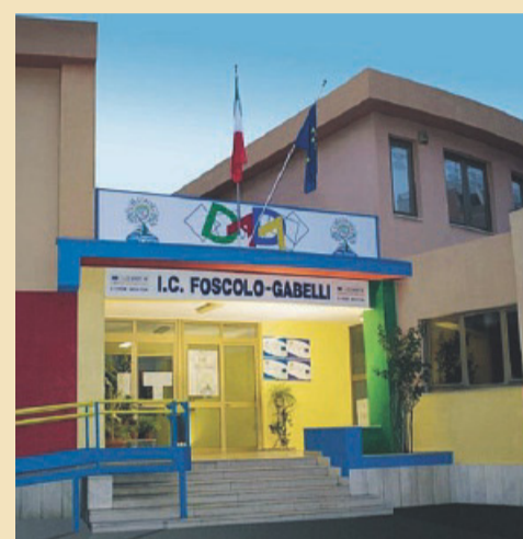
FOGGIA L'istituto "Foscolo"
